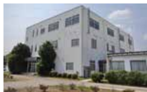
▲フッ素樹脂塗料塗装研究所
