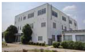
▲フッ素樹脂塗料塗装研究所
