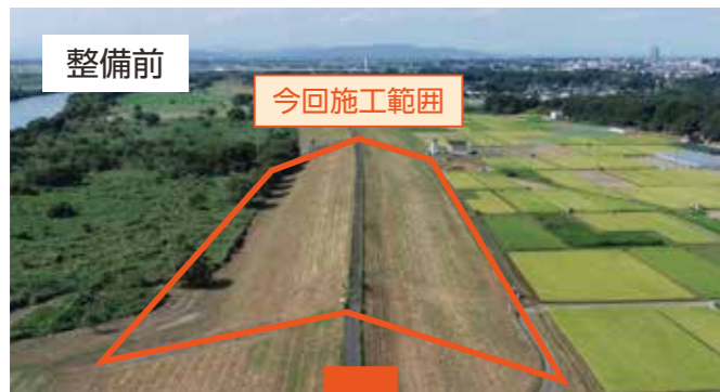
R3 渡良瀬川左岸鳥喰築堤工事
