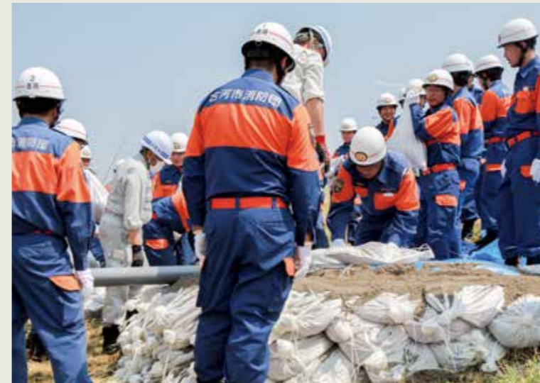
▲土のうを積み上げて堤防からの漏水を止める「月の輪工法」を行う団員
