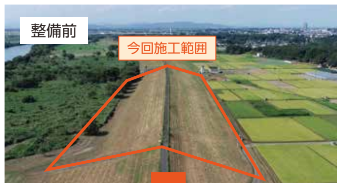
R3 渡良瀬川左岸鳥喰築堤工事
