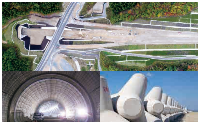
▲地盤改良、土木、ブロック環境の3つの技術で国土づくりに貢献しています
