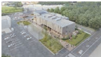
▲上空から見た外観
