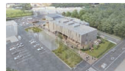
▲上空から見た外観
