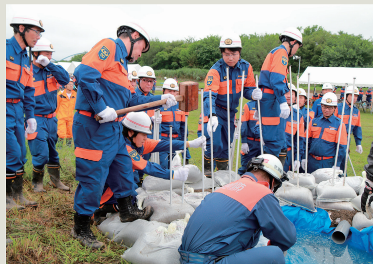
▲土のうを積み上げ、堤防の決壊を防ぐ「月の輪工法」を行う団員
