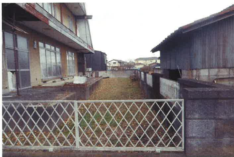
⑤南側の状況 西方から撮影
