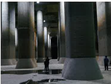
調圧水槽内部
