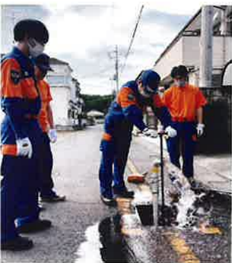
各町内の消火栓点検作業
