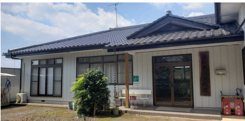
▲大規模修繕工事が完了し見違える様になった公民館
