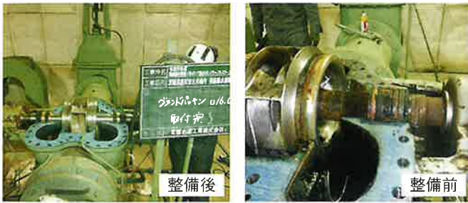
工 事 名：令和5年度 羽黒揚水機場 1号ポンプ 揚水ポンプシャフトスリーブ交換工事 場 所：桜川市大月地内（羽黒揚水機場） 事 業 費：5,390千円
