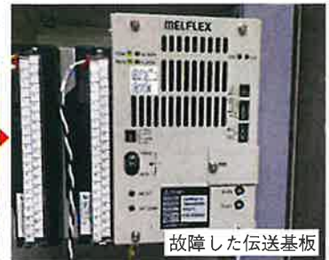
板敷吐水槽の遠方監視装置
