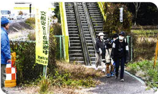
国道新4号バイパス歩道橋
