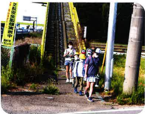
新4号バイパス高野歩道橋
