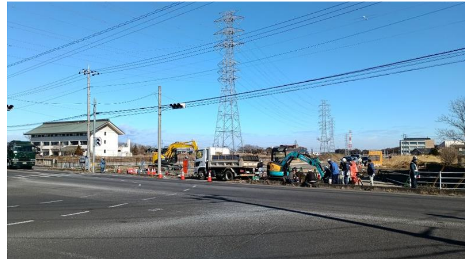
西牛谷辺見線の工事状況
