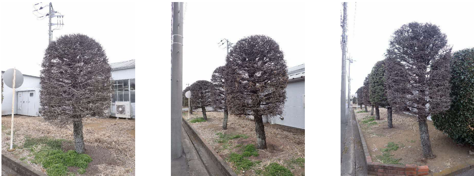
枯木撤去工事
