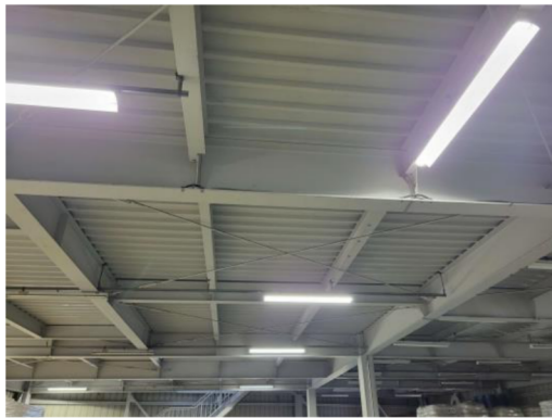
<倉庫 LED 照明化>
