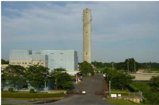
「古河クリーンセンター」
