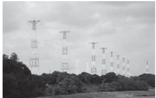
鉄塔が林立する八俣送信所
