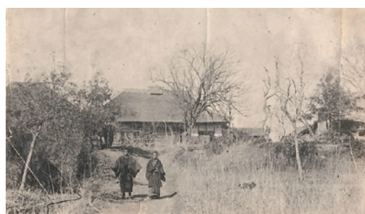
▲谷中村下宮の茂呂近助家の屋敷 明治42年の撮影とみられる(当時の谷中の景観をよくあらわしているといわれる(茂呂正俊氏写真提供))
