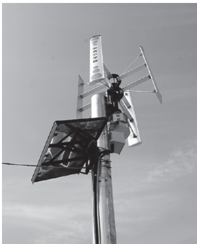
▲中央小学校のハイブリッド型風力発電装置。環境教育に役立っています
