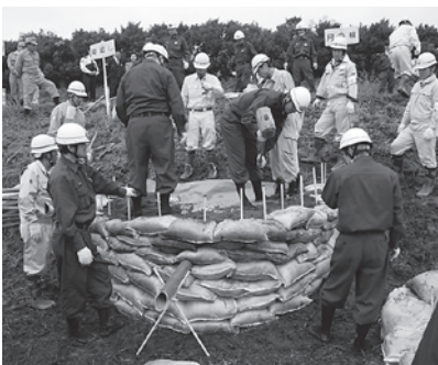
▲月の輪工(半円状に土のうを積み、川の水位と漏水口との水位差を縮めて圧力を弱め、水漏れが広がるのを防ぎます)
