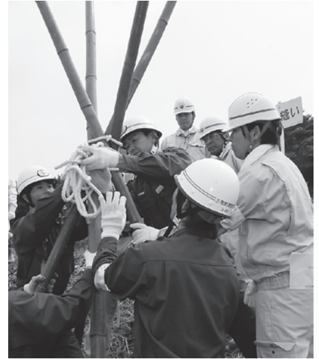
▲五徳縫い工(堤防の亀裂を挟んで3～4本の竹を三脚形または四脚形に突き刺し、亀裂の拡大を防ぎます)
