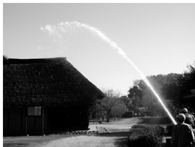
▲民家園の周囲4カ所に放水銃があります
