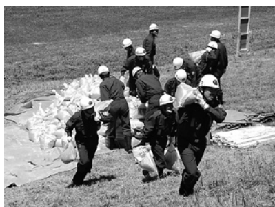
▲土のうを担いで土手の上に積み上げます
