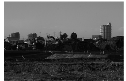
▲日赤病院の移転地の造成工事が進んでいます
