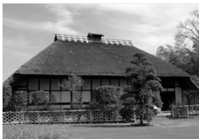
▲猿島郡地方で多く見られた直屋型の代表的な民家(旧茂田家)
