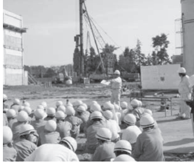
▲全長20メートルのコンクリート杭を全部で164本埋め込みました
