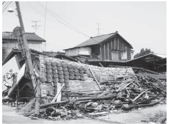
▲新潟中越地震で倒壊した家屋の様子②
