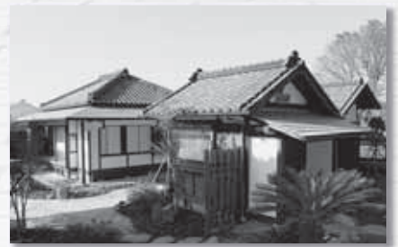
▲改修移築された画室「繡水草堂」
