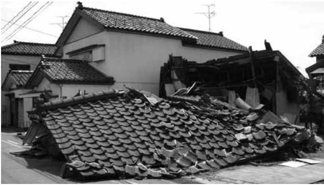
▲平成19年7月 新潟県中越沖地震で倒壊した家屋
