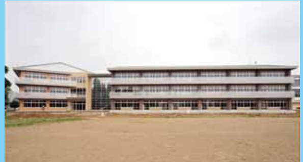
▲総和中学校新校舎竣工
