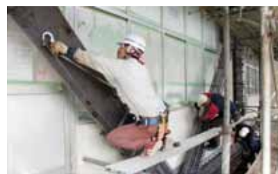
教室の外の補強工事の様子
