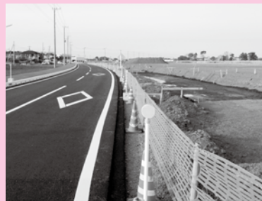
▲周辺道路の整備も進んでいます
