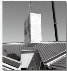
▲外部空調機の取り付け
