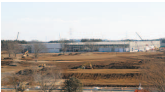
工場の建設が進む名崎工業団地(平成24年2月末撮影)
