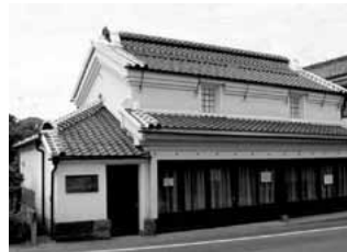
▲修復補強工事の終わった永井路子旧宅
