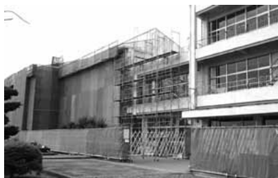
▲耐震工事が進む上大野小
