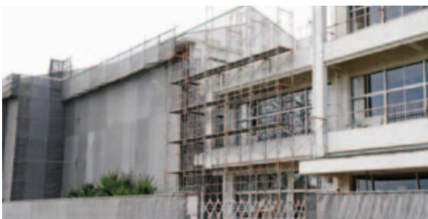
学校の耐震化を進めます
