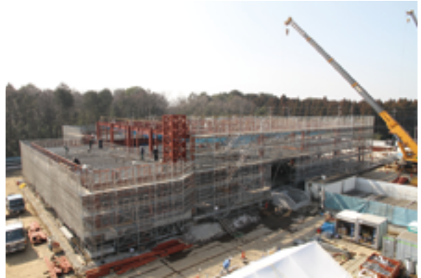
▲建設が進む新学校給食センター
