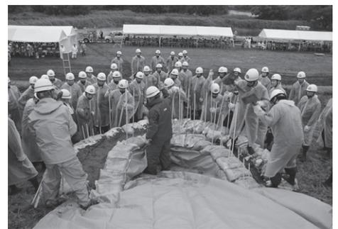
▲「月の輪」と呼ばれる水防技術を使った応急処置にも挑戦。堤防の漏水箇所付近に土嚢を半月状に積んで決壊を食い止めます
