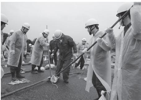
▲堤防天端(堤防の平坦になった頂部)の亀裂拡大を防止する「折り返し」
