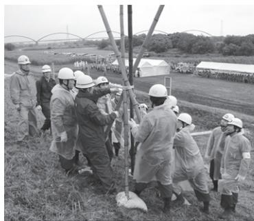
▲「五徳縫い」は亀裂を挟んで竹を刺し、竹を縛ってその弾力を利用して亀裂がそれ以上広がらないようにする工法
