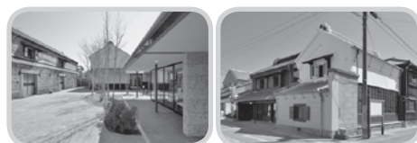
▲地域の景観を壊さないよう十分に配慮して、改修工事を行いました
