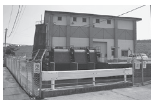
③ 中田排水機場
