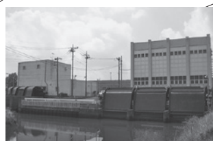
④ 大山沼排水機場
