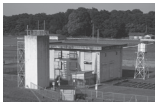
② 新郷排水機場
