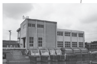
⑤ 积水排水機場
