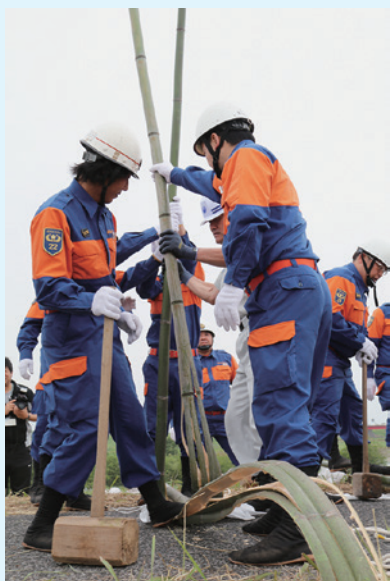
堤防天端(堤防の平たんになった頂部)の亀裂拡大を防止する
