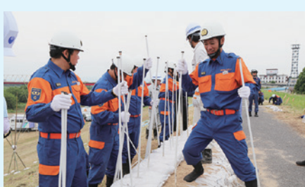
堤防天端(堤防の平たんになった頂部)の亀裂拡大を防止する
