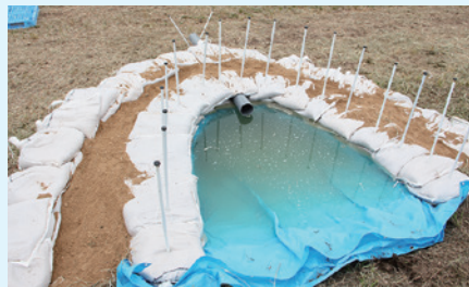
堤防の漏水箇所付近に土のうを半月状に積んで決壊を食い止める応急処置
