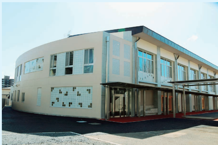
▲学校行事や地域の学校開放等で活用される屋内運動場
