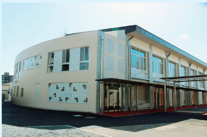
▲学校行事や地域の学校開放等で活用される屋内運動場
