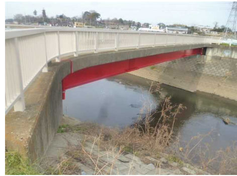
長寿命化対策を行った東諸川橋
