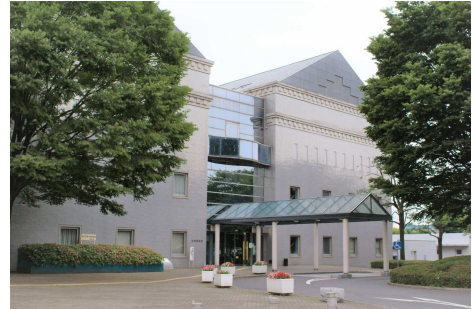
古河市役所古河庁舎
