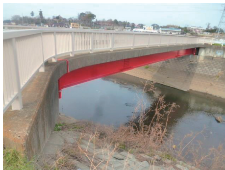
長寿命化対策を行った東諸川橋
