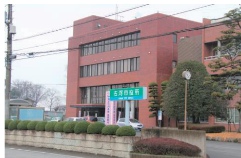
古河市役所総和庁舎
