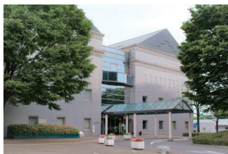
古河市役所古河庁舎
