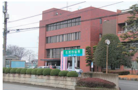
古河市役所総和庁舎
