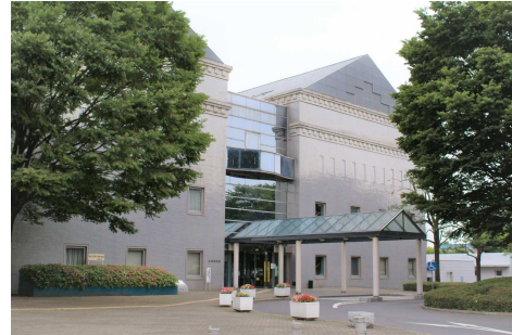
古河市役所古河庁舎
