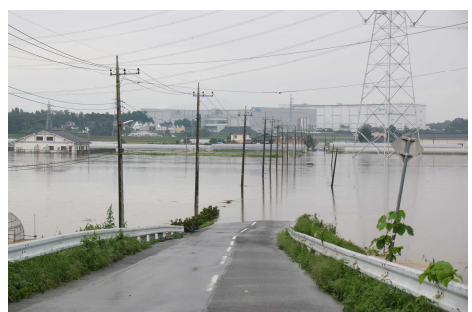
東山田調整池周辺での浸水被害の状況
